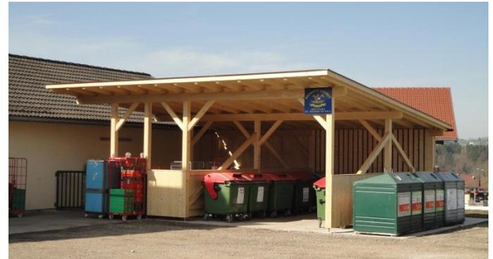
Die Holzkonstruktion mit seitlicher Wandverschalung inkl. Eindeckung wurde von der Zimmerei Baumann Helmut, St. Georgen errichtet, die Beton-Fundamente (Bodenplatte) sowie die Versetzung eines Regenwasser-Sickerschachtes wurde von unserem Bauhof-Team ausgeführt.
